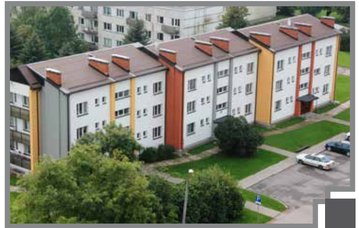
Pilsrundāles ciemā tika veikta „Kuršu”, „Sēļu” un „Zemgaļu” daudzdzīvokļu dzīvojamo māju siltināšana
